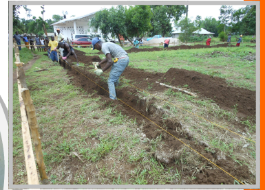
Si inizia a scavare...
