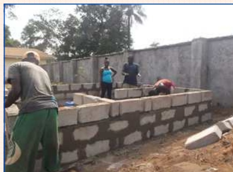
LAVORI DI COSTRUZIONE DELLA CUCINA
